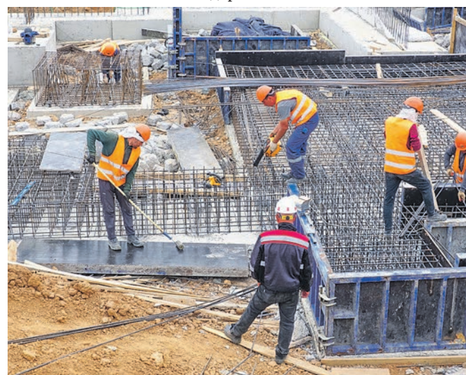
Стройка идёт полным ходом
