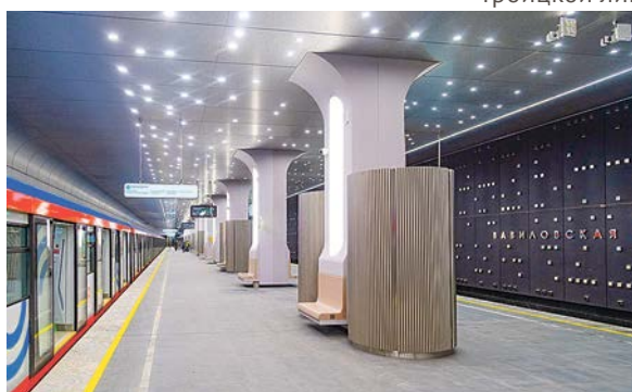
Станция метро «Вавиловская» Троицкой линии
